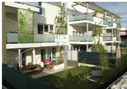
Les extérieurs des logements
