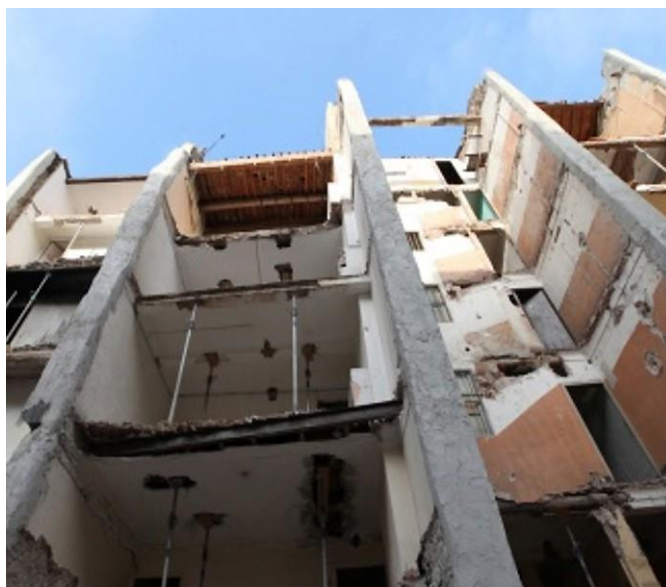
Des immeubles du centre ancien en cours de rénovation
