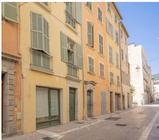
Une rue du centre ancien après rénovation
