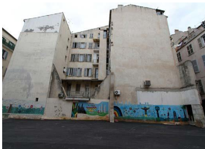
Ilot Globe Savonnières Nord - Avant rénovation urbaine
