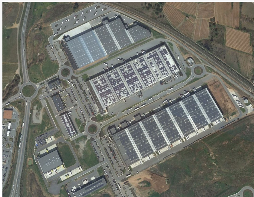
Parc logistique des Bréguières Les Arcs Bâtiments performants, production ENR
