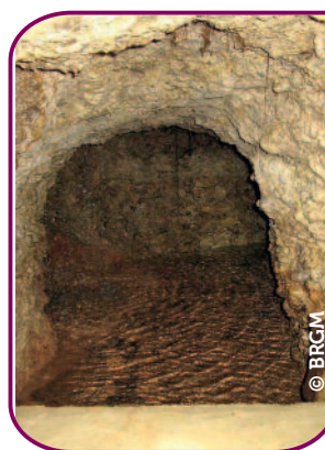
Galerie creusée à travers les poudingues pour récupérer l'eau souterraine
