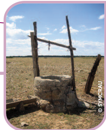
Puits de la Bergerie Nappe de la Crau (13)
